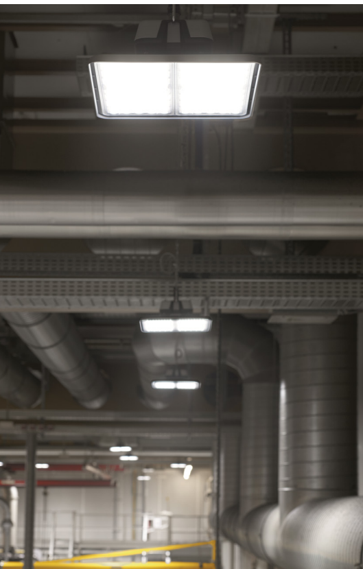
Bild 1: LED-Tiefstrahler zur flächigen Grundausleuchtung von Gebäuden mit hoher Raumhöhe. Copyright: Herbert Waldmann GmbH & Co. KG
