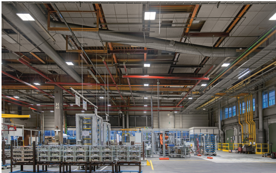
Bild 2: Gute Lichtqualität und gleichmäßige Beleuchtung mit energieeffizienten LED-Strahlern. Copyright: Herbert Waldmann GmbH & Co. KG
